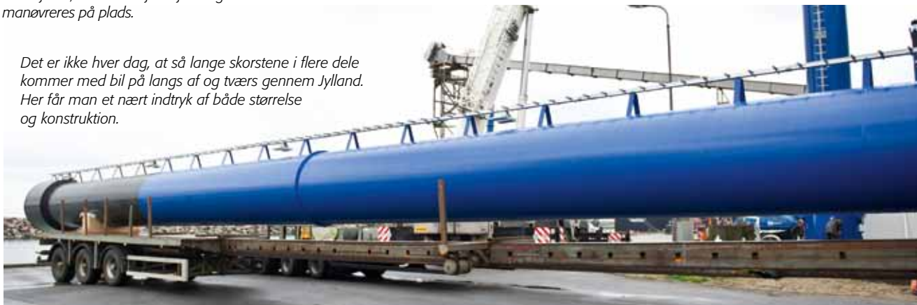
Den øverste sektion på vej op mod de 60 meter.
